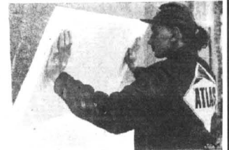
Przyklejanie płyty styropianowej.
