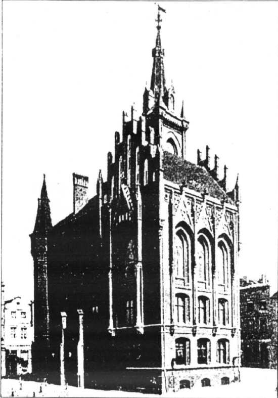
Ratusz po przebudowie. W latach 1878-1880. Zdjęcie wykonano w 1925 roku
