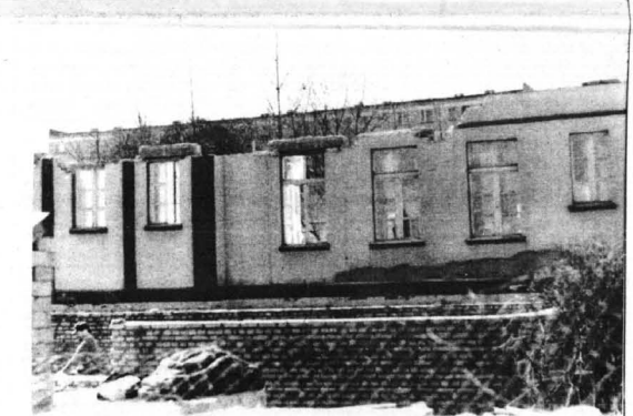
Dawny oddział zakaźny w przebudowie
