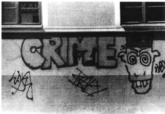
Graffiti na ścianie budynku przy ul. Tęczowej
