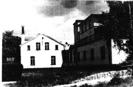
Kolejnym etapem modernizacji będzie dobudowanie nowego pawilonu
