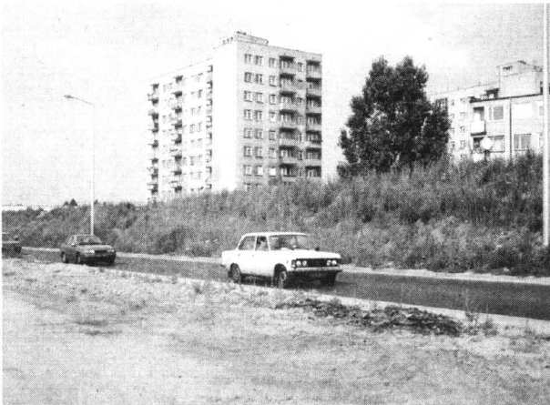
Koszt umocnienia (aby nie spłynął z deszczem) i utrzymania takiego niby ekranu akustycznego, mającego chronić mieszkańców osiedla przed hałasem jest dużo wyższy od instalacji ekranów zaprojektowanych profesjonalnie, a ponadto skuteczność nieumiejętnie wzniesionego wału ziemi jest prawie żadna, o jego “estetyce” nie mówiąc...
