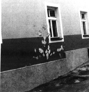
Ta kamienica była malowana w 1994 r. Teraz płatami odpada z niej farba
