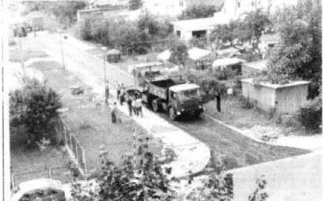
Na wielu kwidzyńskich ulicach trwają prace
