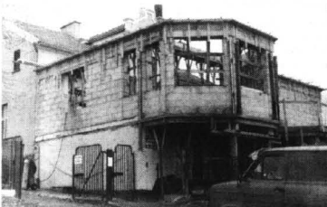
Twa modernizacja DPS
