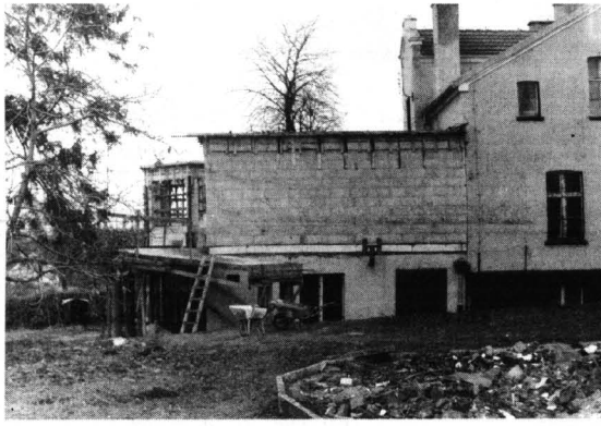
Rozbudowana zostanie stara część Domu Pomocy Społecznej.
