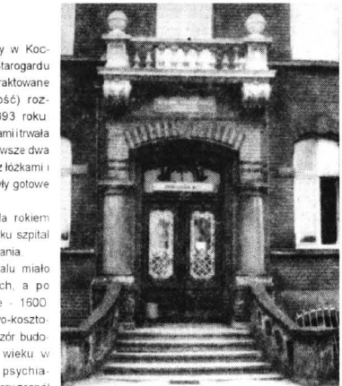
Starannie dopracowane detale głównego wejścia do budynku administracyjnego
