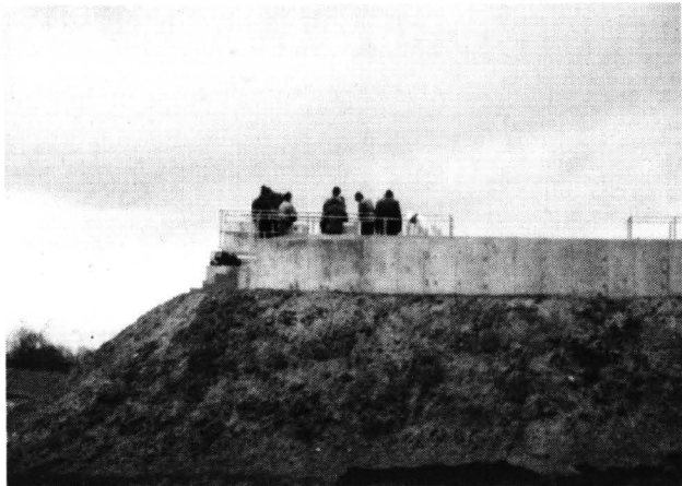
Prace na terenie oczyszczalni ciągle trwają i nikt nie potrafi powiedzieć, kiedy się skończą i z jakim efektem...
