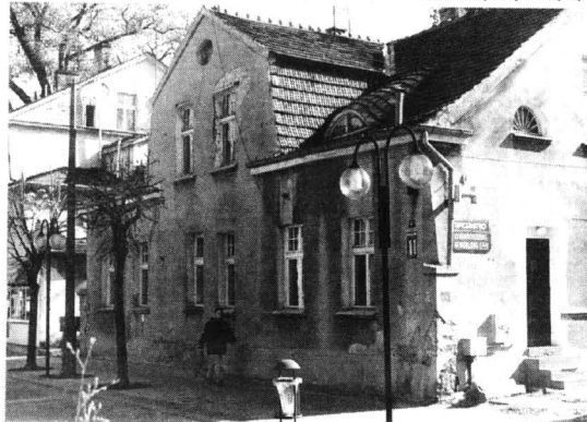
Właściciel lokalu w tym budynku przy ul. Piłsudskiego nie wyraża zgody na remont
