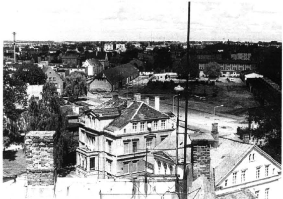
Na zdjęciu widoczny jest fragment ulicy Kopernika wraz z budowanym przy tej ulicy nowym targowiskiem
