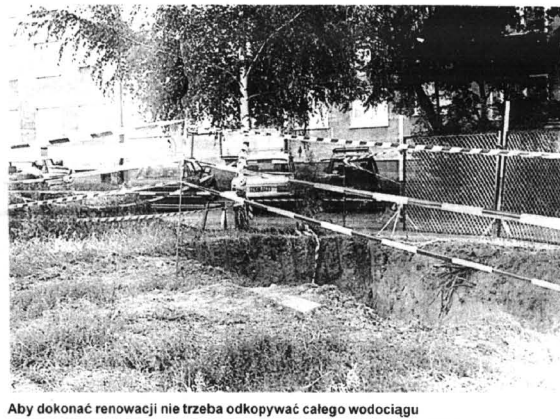
Aby dokonać renowacji nie trzeba odkopywać całego wodociągu
