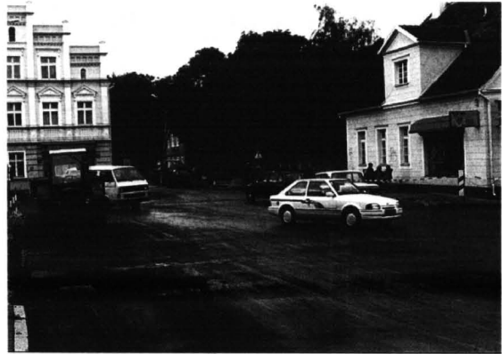
Budowa ronda na skrzyżowaniu ulic: Hallera, Grudziądzkiej i Batalionów Chłopskich zakończona zostanie do grudnia 1997 roku
