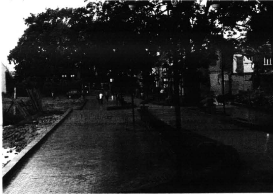
Do końca roku zostanie oddane do użytku przejście z ulicy Piłsudskiego do ulicy 15 Sierpnia
