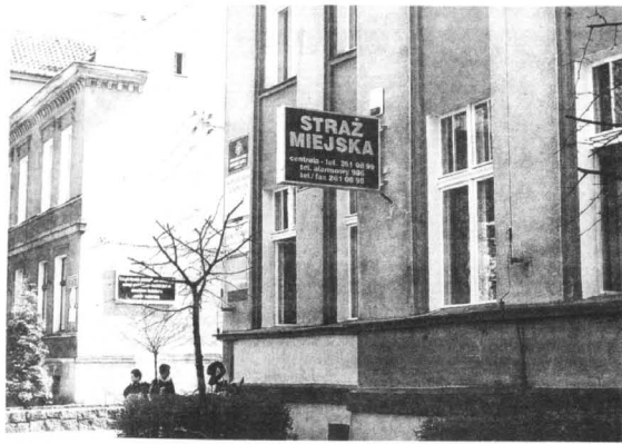
53 tysiące złotych kosztowała adaptacja pomieszczeń przy ul. Warszawskiej
