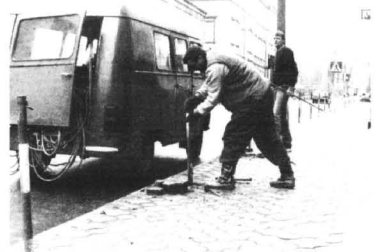
Ekipa remontowa usunęła stare słupki z ulic Sztumskiej i Braterstwa Narodów
