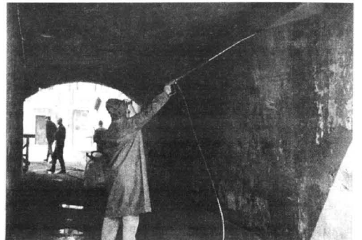
Powoli znajduje się środki na odgrzybienie i remont zabytkowych domów
