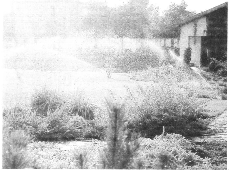
Nawadnianie zraszaczami wyrzutowymi. W instalacji zamontowano najpopularniejsze bijkowe zraszacze obrotowe. Niektóre obracają się dookoła, inne zaś po określonym łuku. Obserwując z boku strumień wody, można zauważyć, że jest on podzielony na krótkie odcinki, przesunięte względem siebie
