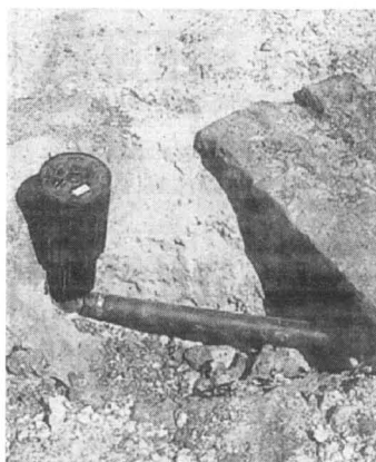
Instalację nawadniającą montuje się na głębokości 15-30 cm. Zraszacze wyrzuszają się z ziemi pod wpływem ciśnienia wody. Po zakończeniu podlewania cofają się do obudowy i nie zajmują miejsca na trawniku
