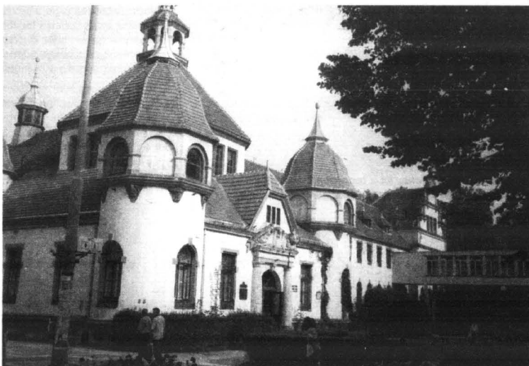
Zakład Balneologiczny, usytuowany przy wejściu na molo. Obiekt zbudowany w latach 1903-1904. Dziś wymaga gruntownego remontu, w tym wymiany wszystkich instalacji wewnętrznych.
