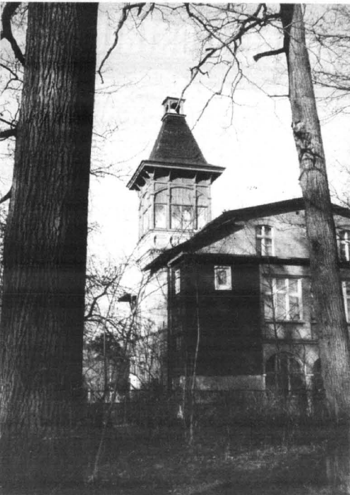
Takie fantastyczne domki stawiano niegdyś w Sopocie. Te, które przetrwały złe czasy, trzeba pilnie ratować. W tym domu z wieżyczką mieści się obecnie przedszkole.
