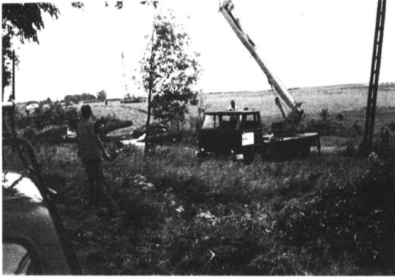
Energetycy podczas usuwania skutków burzy
