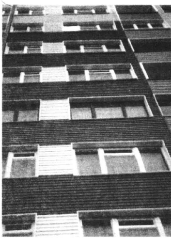
Elewacja metalowa typu siding
