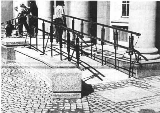
Podjazdy dla niepełnosprawnych
