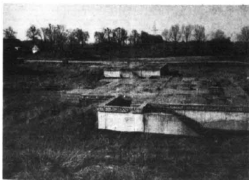
Fundamenty przyszłych bloków mieszkalnych
