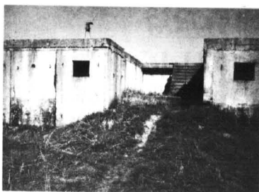
To nie schron - to fundamenty bloku
