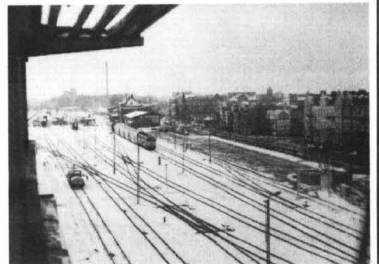
Z okna wieży widać cały teren stacji
