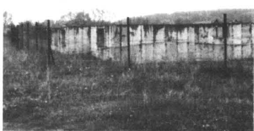
Za tym płotem miały powstać budynki mieszkalne
