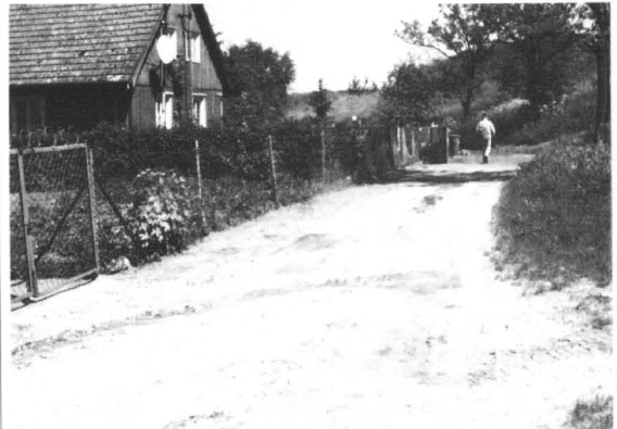
Na ul. Poligonowej nie ma nawierzchni, kanalizacji ani gazociągu
