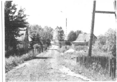
Drógę wyłożono żutym asfaltem
