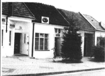
Nowy urząd pocztowy znajduje się przy ul. Kasprówicza 20 C
