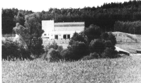
Stacja uzdatniania wody w Kamionce
