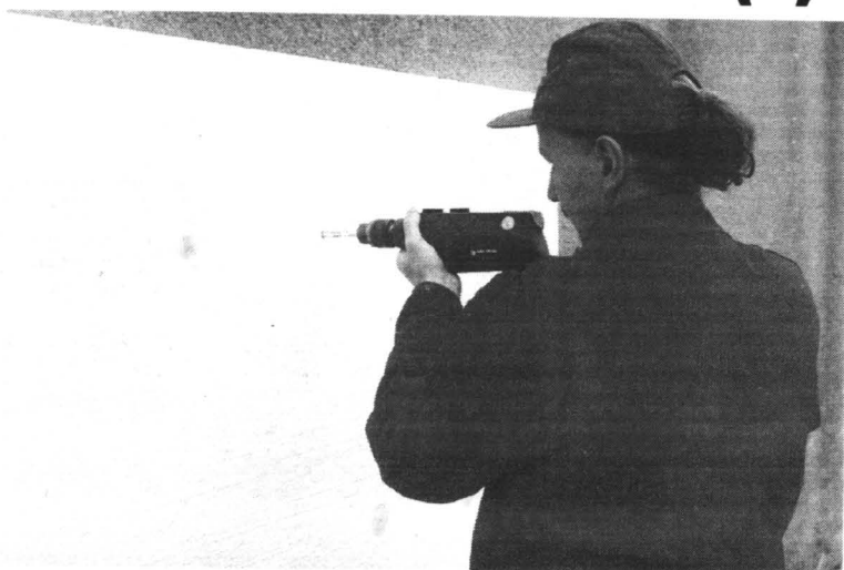
Wiercenie otworów do kółek przytrzymujących styropian
