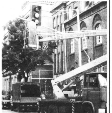
Do końca sierpnia sygnalizację świetlną zamontowano w pięciu miejscach
