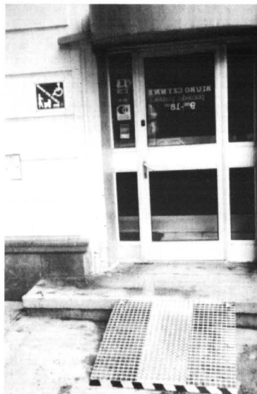
Krata-podjazd otwiera drzwi do każdego sklepu
