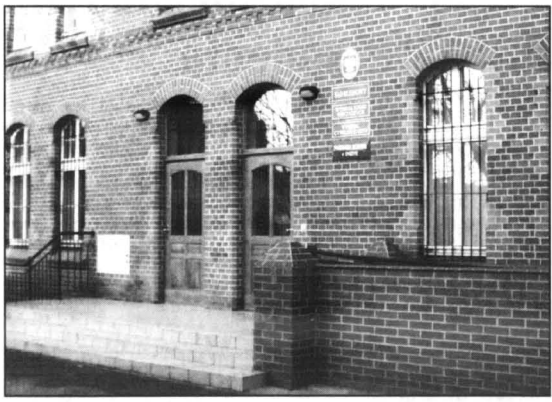
Nowa siedziba Sądu Rejonowego w Kwidzynie przy ul. Kościuszk 30 A
