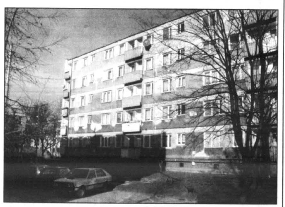
str. 3 Ściana północna bloku przy ulicy Spółdzielczej 16
