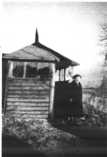
Jeszcze można spotkać na Pomorzu stare, drewniane, lecz jakże romantyczne wiaty przystankowe. Na zdjęciu wiatu w Rzeżęcinie powiat czeski Fot. S. Sierko
