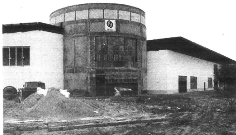
Na gdyniskim Skwerze Kościuszki dobiegają końca roboty budowlane Centrum Rozrywki Gemini. Wyposażenie potrwą do końca roku
