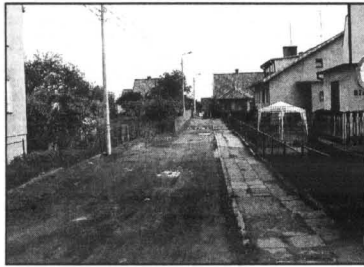
Ul. Wodna przed modernizacją
