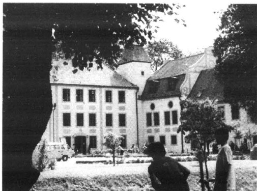
Historyczny obiekt pałacowy przystosowany do działalności hotelowej w ramach Stowarzyszenia Wypoczynek w Zabytkach musi spełniać wymagania tradycyjnego hotelu trzygwiazdkowego
