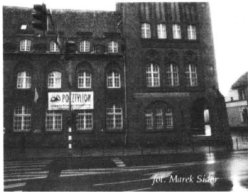
Widok ogólny budynku poczty
