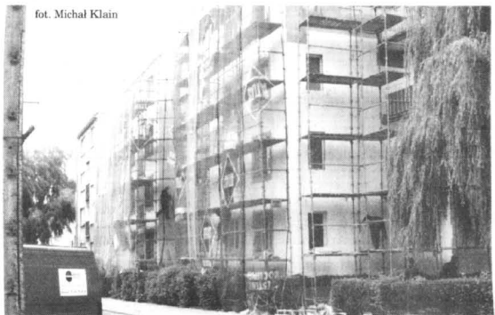
Remontowane bloki przy ul. Batalionów Chłopskich
