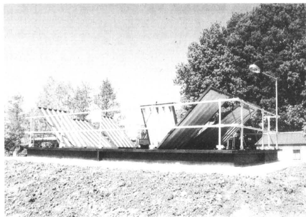
Oczyszczalnia w Rydzówce zbudowana została wg najnowszych technologii
