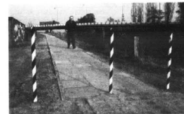
Część chodnika wzdłuż torów kolejowych jest już gotowa
