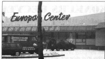
Pawilon Europa Center dla MM Logistic w Olsztynie był kanałem Przedsiębiorstwa Elementów Budowlanych Pelbud
