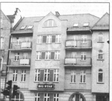
Budynek mieszkalno-usługowy znakomicie komponuje się z kamienicami przy ul. Niepodległości w Iławie. Jego wykonawcą jest ławskie Przedsiębiorstwo Budowlane IPB
