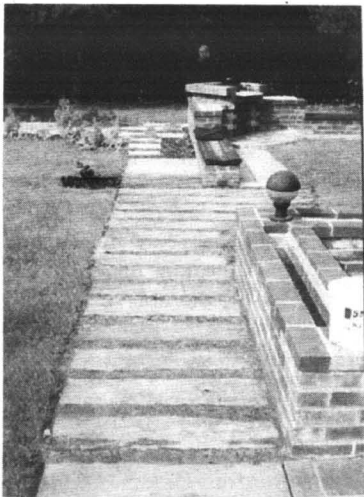
Ścieżka z podkładów położonych w kilkunastocentymetrowych odstępach. Z lewej - świeżo ułożona, z prawej - po dwóch latach, poprzerastana trawą
