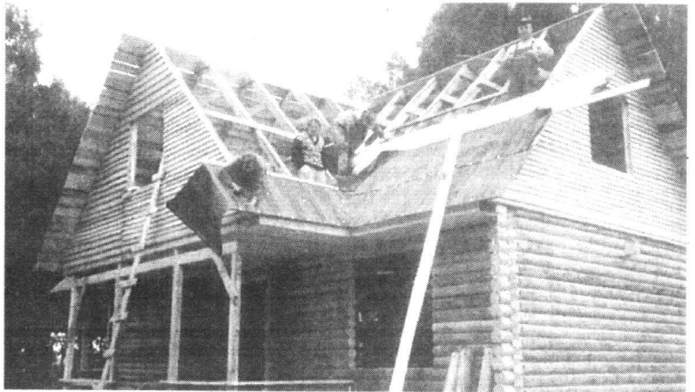
Folia paroizolacyjna na dach, folia paroprzepuszczalna (jednocześnie przeciwwiatrowa) - na ogół bezpośrednio na izolację termiczną
