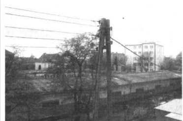
Plagą stały się kradzieże przewodów uprost ze słupów
