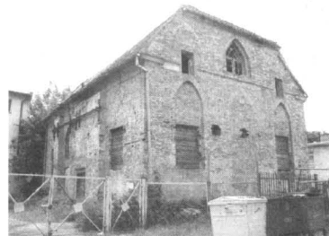
Synagoga potrzebuje natychmiastowego remontu
