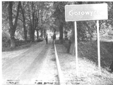
Droga po modernizacji
