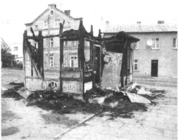
Spalony drewniany budynek przy ulicy Krętej
