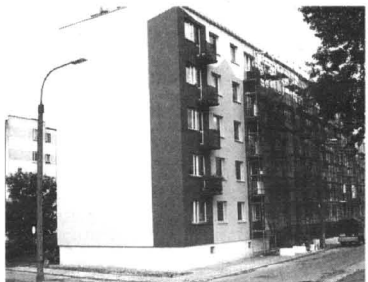
Docieplenie i malowanie bloku przy ulicy Jagotty
