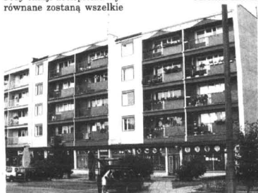
Budynek wyremontowany w zeszłym roku
