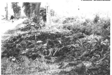
Ziemię z rowu wysypuje się na pobocze, które jeszcze w tym tygodniu zostanie oczyszczone.
