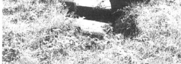
Wiele chodników nie wytrzymało naporu wody ...
