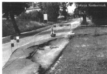
Od wczoraj na tym odcinku drogi wojewódzkiej 521 trwają prace remontowe
