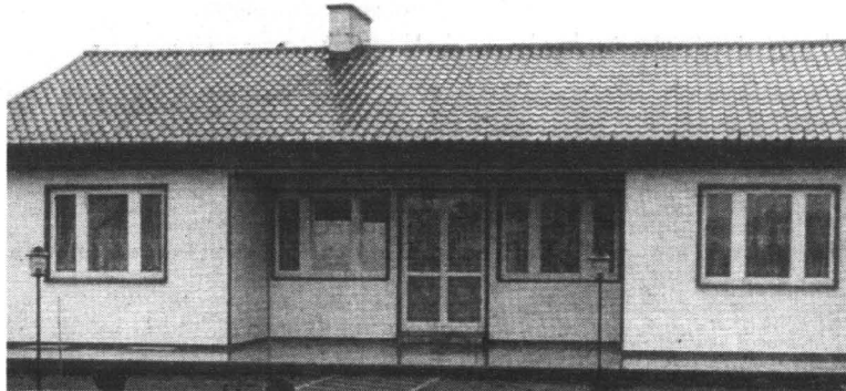
Jednorodzinny domek mieszkalny zbudowany w ciągu miesiąca w systemie famablock i z wykorzystaniem stolarki Zakładu Obróbki Drewna „Dziadek”
