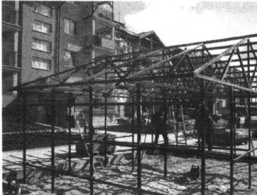
Stelaż wiaty pod śmietniki przy ulicy Szerokiej 13
